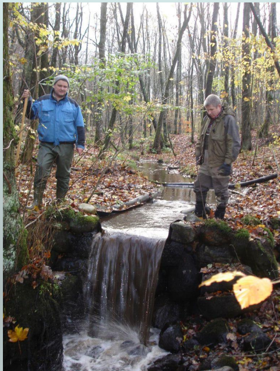
Betonspærring i bækken, kunne ikke fjernes.
