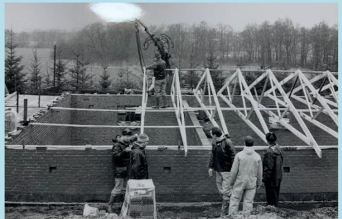
Foto: Byggeri af klækkehus
