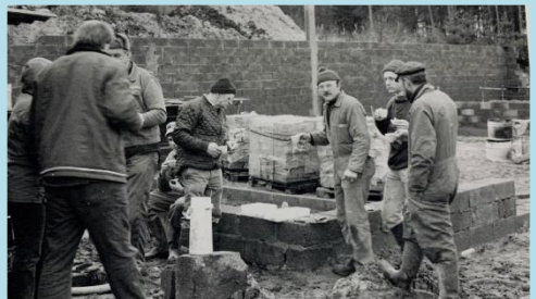
Foto: Byggeri af klækkehus
